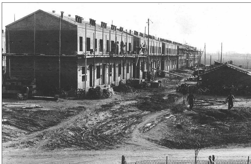
Pontelagoscuro, primo blocco delle case del “villaggio dei marchigiani” in costruzione, 1953 - 1954. (Fonte: Comitato Cristalli nella nebbia - Comune di Ferrara, Cristalli nella nebbia, minatori a zolfo dalle Marche a Ferrara, Ferrara, 1996)
