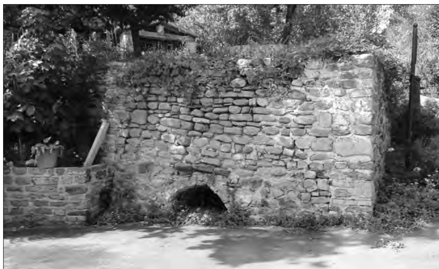
Figura 89. Una fornace a Verginetto Basso, ben conservata nella gola e nel tombolo , parzialmente interrati e completamente rivestiti in pietra. Sopra il tombolo veniva eretta la colmatura .
