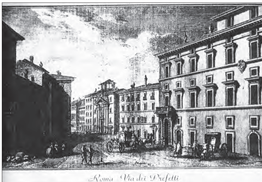
Palazzo Pallavicini-Montoro sede della Mutua dal 1959
