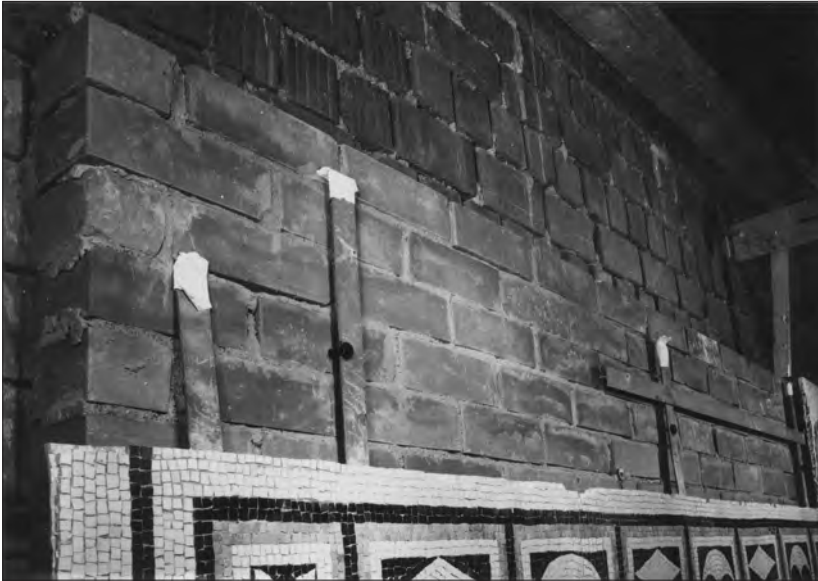
Fig. 6 - Particolari della intelaiatura di ferro su cui è montato attualmente il mosaico, anno 1965.
