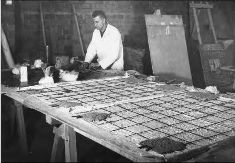
Fig. 4 - Particolari delle lastre in cui fu diviso il mosaico durante il restauro nel periodo 1963-1965.
