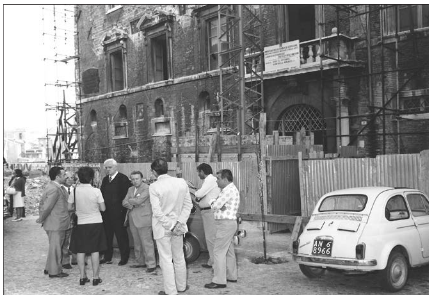
Visita del Rettore dell'università di Urbino Carlo Bo, accompagnato da Trifogli, alla facoltà di Economia e Commercio di Ancona danneggiata dal sisma del 1972
